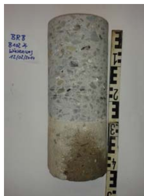
Betonbohrkern aus Fahrbahn
