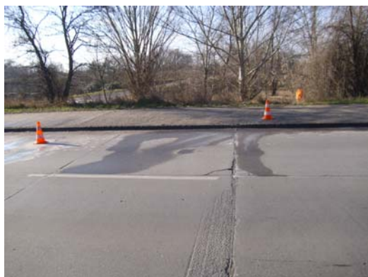
Fahrbahndecke aus Beton
