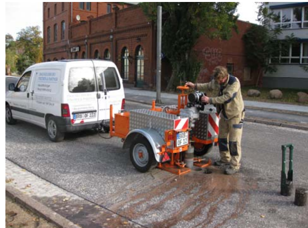
Bohrkernentnahme zur Feststellung der Dicke des Straßenoberbaus
